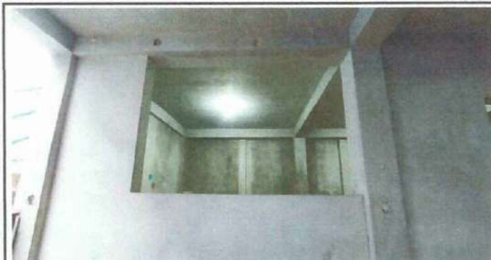
Foto 3: Instalación de ventanales y valcon de vidrio
