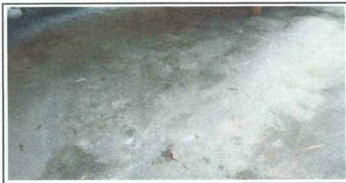
Foto 6: Restauración de piso a piso cerámico
