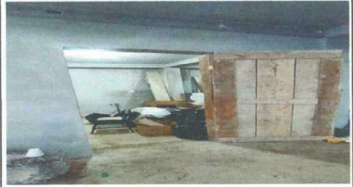
Foto 2: Instalación de puerta de metal
